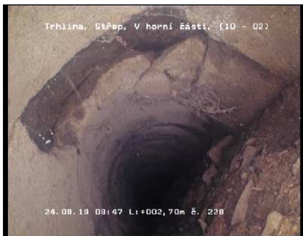
Foto 228 Videopáska: 7/11 Stav RS-O 2,70 m 10 - 2 Uhr Trhlina, Střep, V horní části
