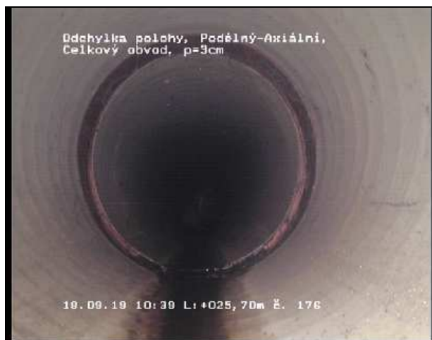
Foto 176 Videopáska: 7/4 Stav LL-- 25,70 m Odchylka polohy, Podélný-Axiální, Celkový obvod, Posunutí = 3cm
