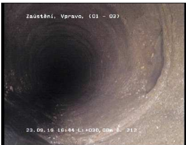
Foto 212 Videopáska: 7/8 Stav S-R 30,00 m 1 - 3 Uhr Zaústění, Vpravo
