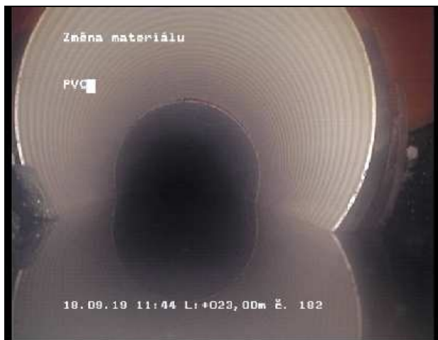
Foto 182 Videopáska: 6/2 Stav WV 23,00 m Změna materiálu; PVC
