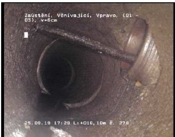
Foto 278 Videopáska: 10/8 Stav SE-R 16,10 m 1 - 3 Uhr Zaústění, Včnávající, Vpravo, Včnávající = 6cm
