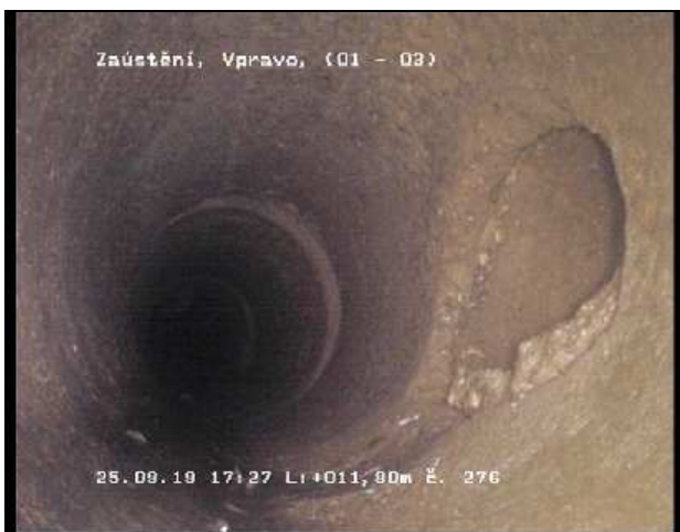
Foto 276 Videopáska: 10/8 Stav S--R 11,80 m 1 - 3 Uhr Zaústění, Vpravo
