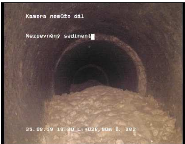
Foto 282 Videopáska: 10/9 Stav TVS 28,90 m Kamera nemůže dál; Nezpevněný sediment
