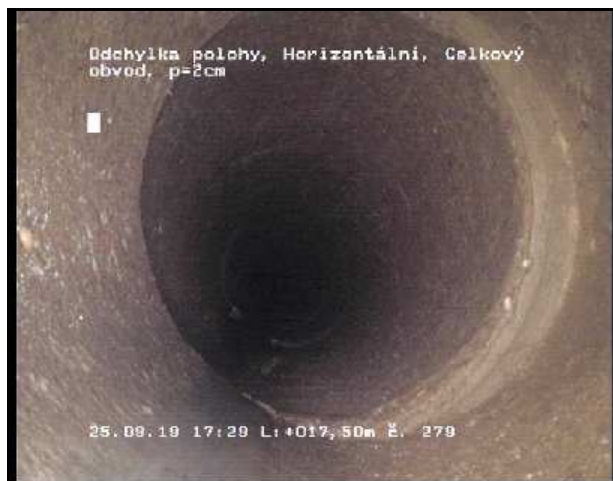
Foto 279 Videopáska: 10/8 Stav LH-- 17,50 m Odchylna polohy, Horizontální, Celkový obvod, Přesazení = 2cm
