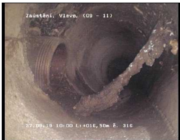
Foto 316 Videopáska: 10/5 Stav S--L 16,50 m 9 - 11 Uhr Zaústění, Vlevo
