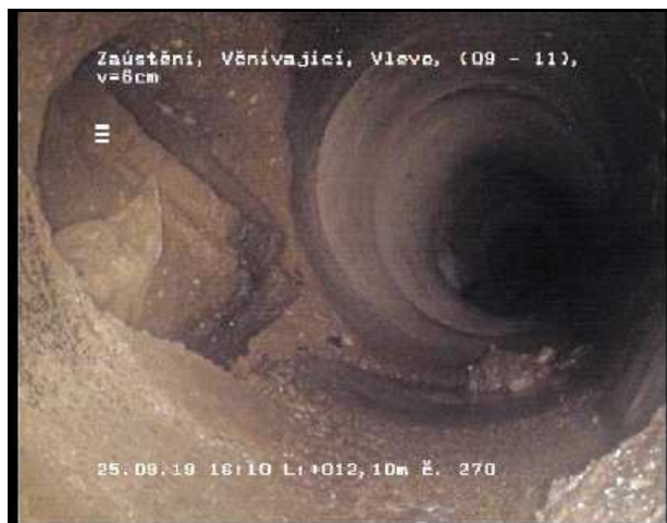
Foto 270 Videopáska: 10/6 Stav SE-L 12,10 m 9 - 11 Uhr Zaústění, Včnivající, Vlevo, Včnivající = 6cm
