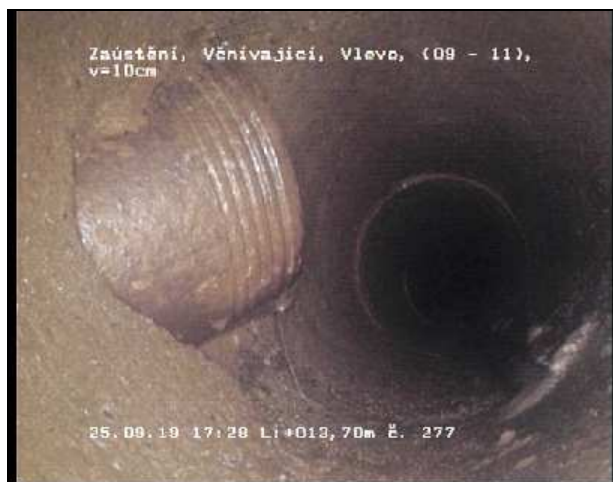
Foto 277 Videopáska: 10/8 Stav SE-L 13,70 m 9 - 11 Uhr Zaústění, Včnávající, Vlevo, Včnávající = 10cm
