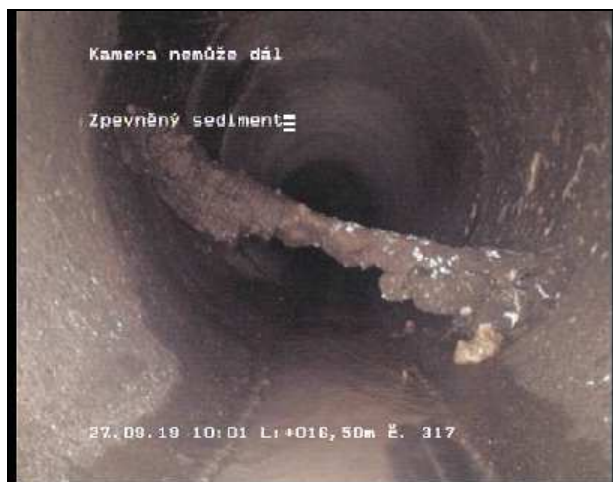
Foto 317 Videopáska: 10/5 Stav TVS 16,50 m Kamera nemůže dál; Zpevněný sediment
