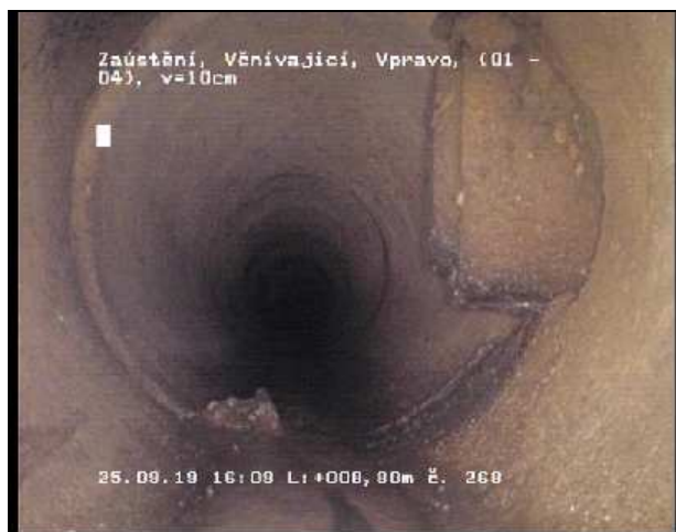
Foto 268 Videopáska: 10/6 Stav SE-R 8,80 m 1 - 4 Uhr Zaústění, Včnivající, Vpravo, Včnivající = 10cm
