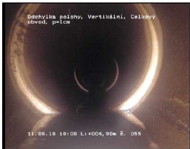
Foto 055 Videopáska: 2/3 Stav LV-- 4,90 m Odchylna polohy, Vertikální, Celkový obvod, Přesazení = 1cm
