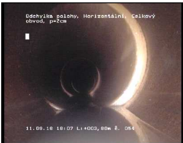
Foto 054 Videopáska: 2/3 Stav LH-- 3,80 m Odchylna polohy, Horizontální, Celkový obvod, Přesazení = 2cm
