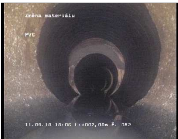
Foto 052 Videopáska: 2/3 Stav WV 2,00 m Změna materiálu; PVC
