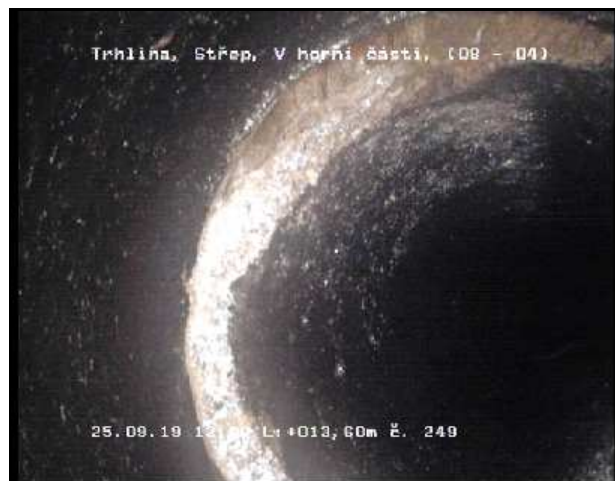
Foto 249 Videopáska: 9/4 Stav RS-O 13,60 m 8 - 4 Uhr Trhlina, Střep, V horní části
