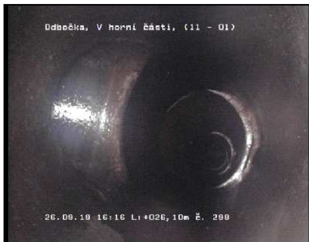
Foto 298 Videopáska: 3/13 Stav A--O 26,10 m 11 - 1 Uhr Odbočka, V horní části
