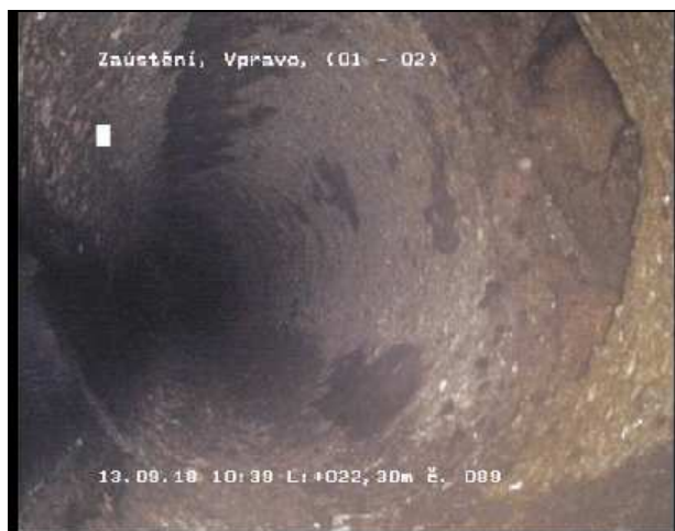
Foto 089 Videopáska: 3/5 Stav S--R 22,30 m 1 - 2 Uhr Zaústění, Vpravo
