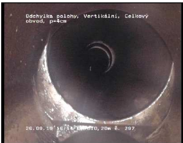
Foto 297 Videopáska: 3/13 Stav LV-- 10,20 m Odchylka polohy, Vertikální, Celkový obvod, Přesazení = 4cm
