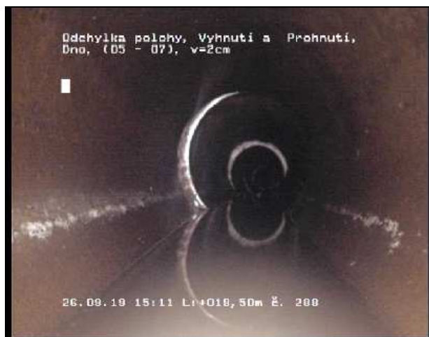
Foto 288 Videopáska: 3/10 Stav LB-U 19,50 m 5 - 7 Uhr Odchylnka polohy, Vyhnutí a Prohnutí, Dno, Vyhnutí = 2cm; V délce od 19,50 do 20,90m
