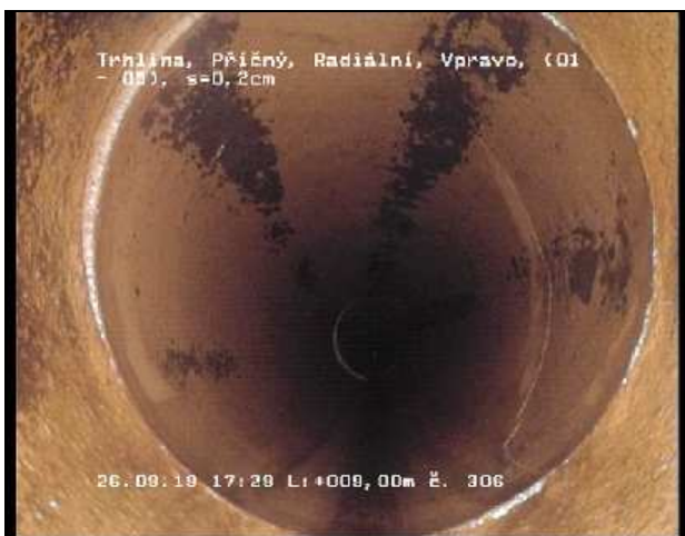
Foto 306 Videopáska: 3/16 Stav RQ-R 9,00 m 1 - 5 Uhr Trhlina, Příčný, Radiální, Vpravo, Šířka trhliny = 0,20cm
