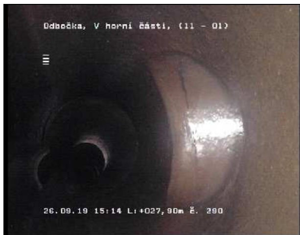
Foto 290 Videopáska: 3/10 Stav A--O 27,90 m 11 - 1 Uhr Odbočka, V horní části
