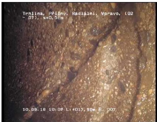
Foto 007 Videopáska: 1/2 Stav RQ-R 17,50 m 2 - 7 Uhr Trhlina, Příčný, Radiální, Vpravo, Šířka trhliny = 0,50cm
