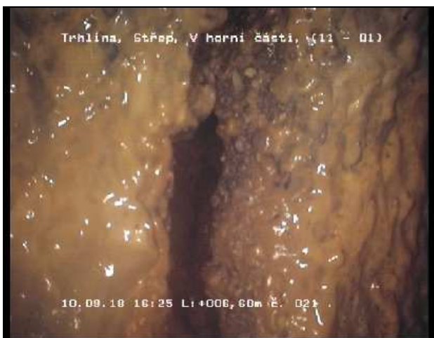
Foto 021 Videopáska: 1/9 Stav RS-O 6,60 m 11 - 1 Uhr Trhlina, Střep, V horní části
