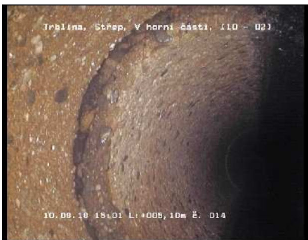
Foto 014 Videopáska 2: 1/5 Stav RS-O 5,10 m 10 - 2 Uhr Trhlina, Střep, V horní části
